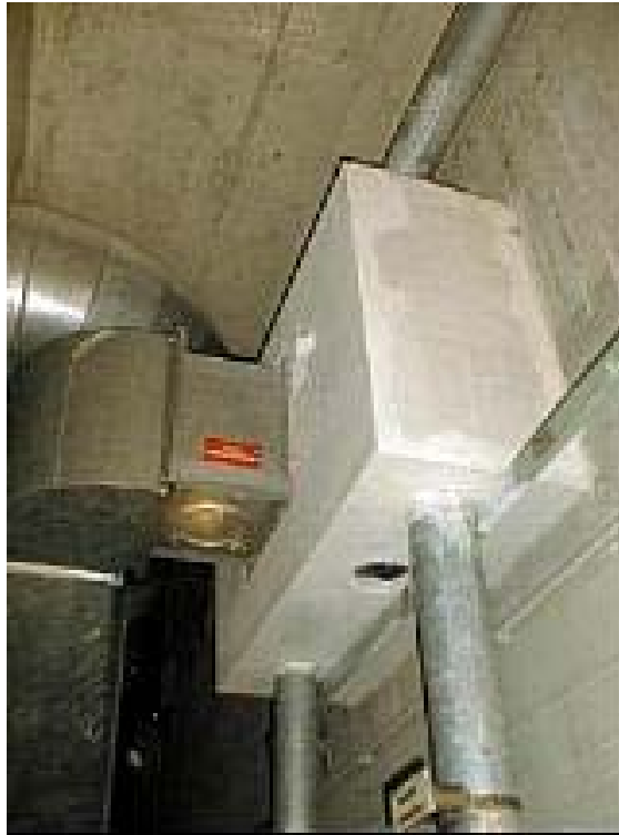
Abb. 3: Asbestverkleidete Entlüftungsanlage
