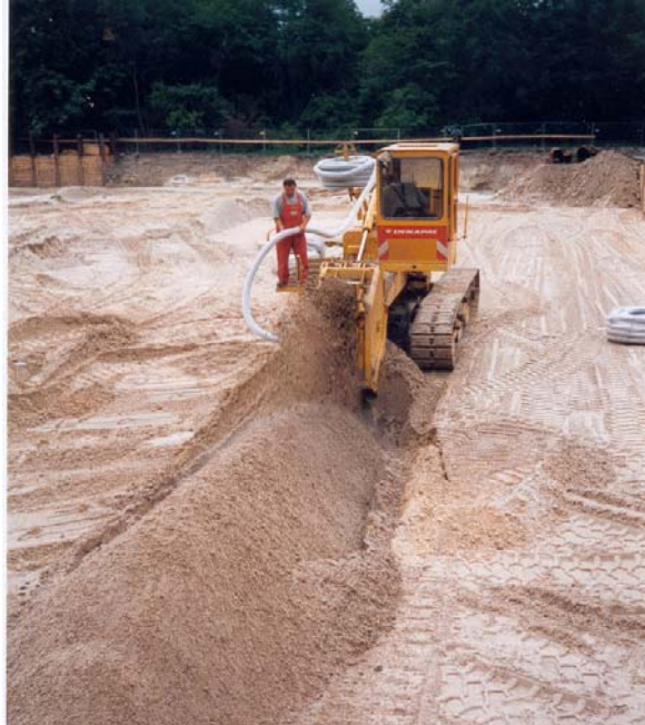
Abb. 4: Einfräsen der Horizontaldränagen mit der Schlitzfräse
